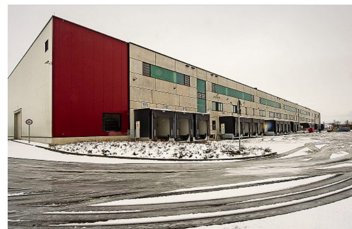
Das neue Gefahrenstofflager hat eine Gebäudefläche von 17.000 Quadratmetern. Es entspricht höchsten Sicherheitsstandards und gilt als absolut sicher.
